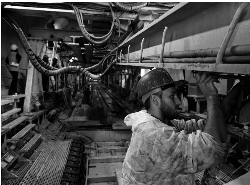
Al lavoro per la costruzione di una nuova stazione della metropolitana di Atene, realizzata con fondi UE
